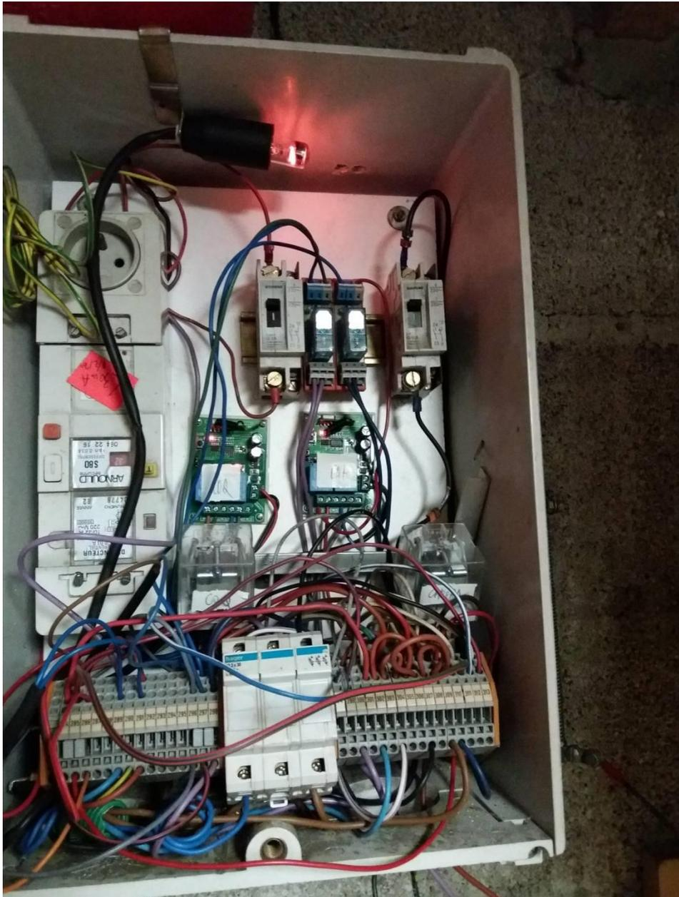
Coffret de commande de la rotation du coq et la rotation du bras caméra
